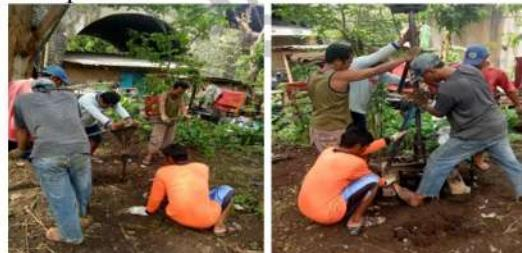
**Gambar 4.** Dilapangan saat mencari data sondir
