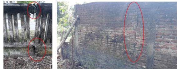
Gambar 1.3 Foto Kerusakan Bangunan Akibat Tanah Ekspansif di Tempat Studi Pustaka yang ditinjau
