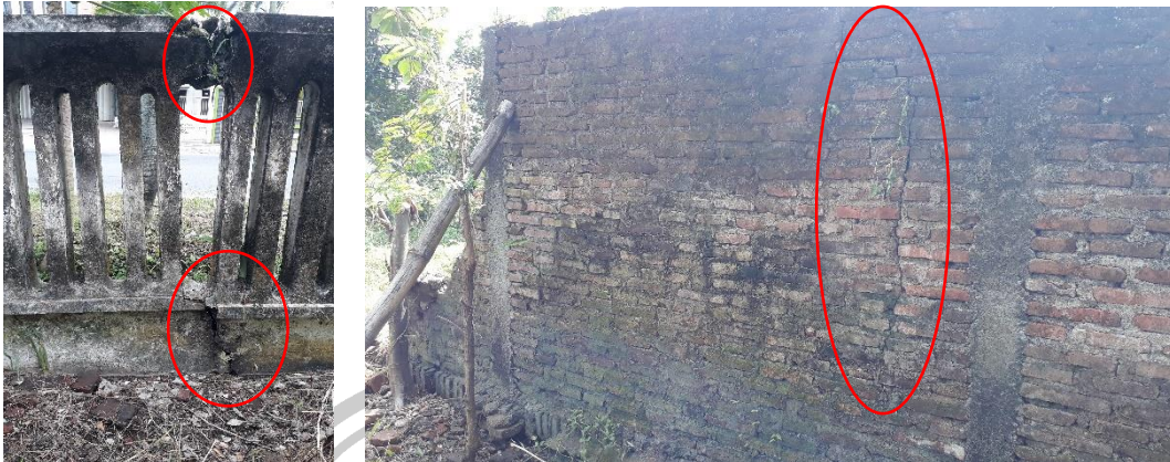
Gambar 1.3 Foto Kerusakan Bangunan Akibat Tanah Ekspansif di Tempat Studi
