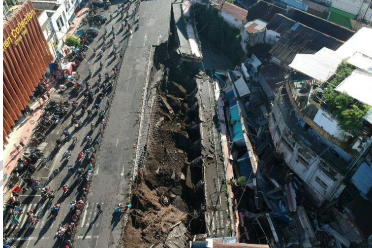
Gambar 1. 3. Ambruknya Bangunan Rumah Toko Jl.Sultan Agung Jember
