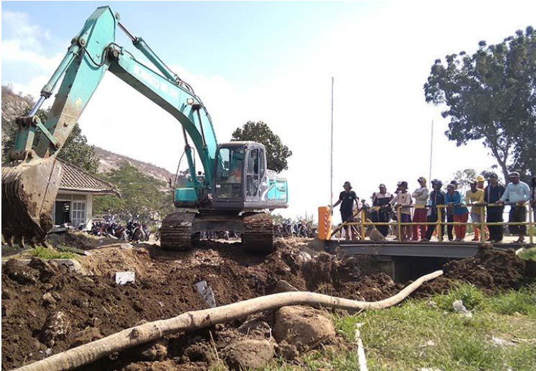
Gambar 6 Proses penimbunan saluran irigasi yang lama ( https://radarjember.jawapos.com/headline/12/07/2019/sepak-at-pembelokan-kanal-irigasi-dihentikan )
