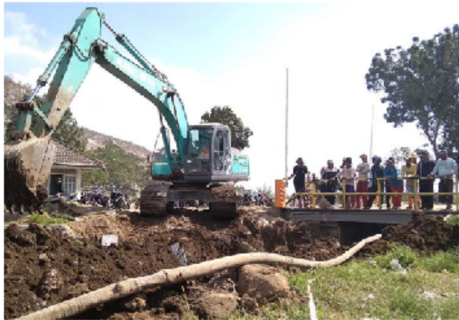
Gambar 6 Proses penimbunan saluran irigasi yang lama ( https://radarjember.jawapos.com/headline/12/07/2019/sepakat-pembelokan-kanal-irigasi-dihentikan )
