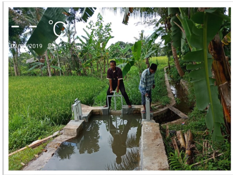
Uji bukaan pintu air dari beton pada kondisi debit air irigasi kondisi rata-rata dan debit penuh
