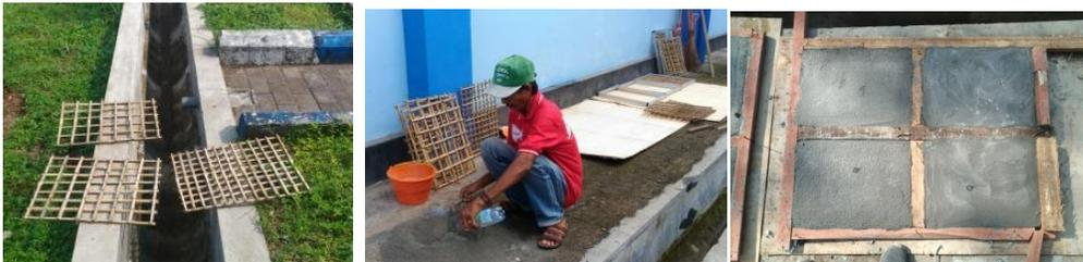
Gambar 3. Proses pengeringan tulangan dan persiapan pengecoran
