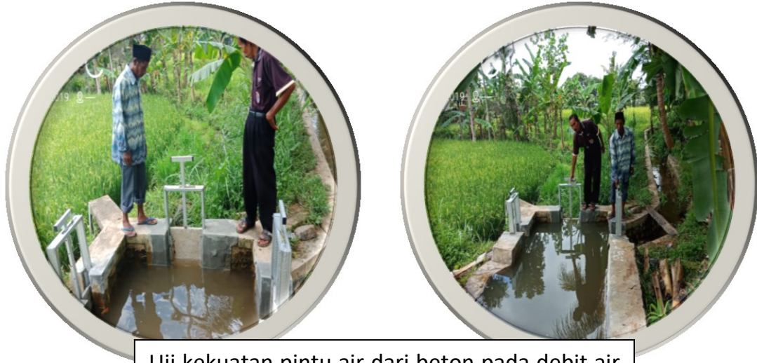
Uji kekuatan pintu air dari beton pada debit air irigasi kondisi rata-rata dan debit penuh
