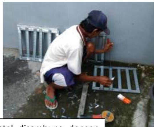
Batang vertikal dan horsonal disambung dengan rapat dengan baut, kemudian jika masih ada sela/lubang-lubang ditutup dengan sealant atau lem.
