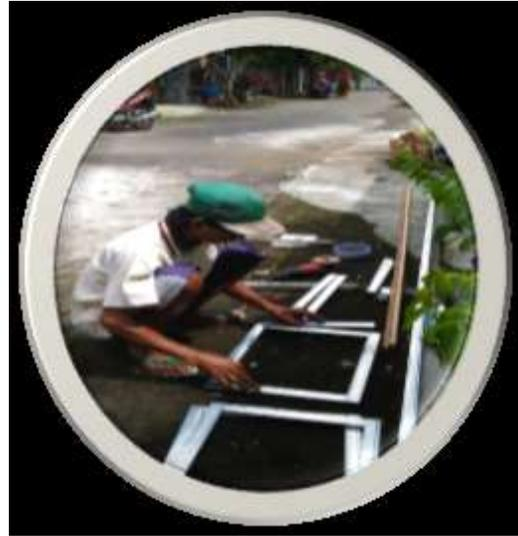
Tulangan pintu air terbuat dari galvalum bentuk hollow uk.20/40. Hollow dipotong dengan panjang 46 cm (vertikal) dan panjang 36 cm (horizontal)
