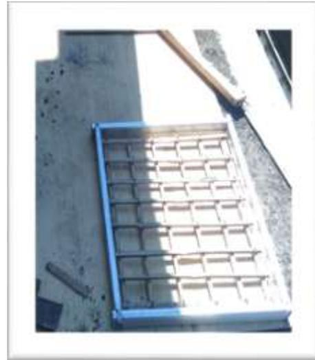
Pembuatan bekisting daun pintu air dari galvalum dan multiplek dan pemasangan bekisting pada tulangan bambu petung
