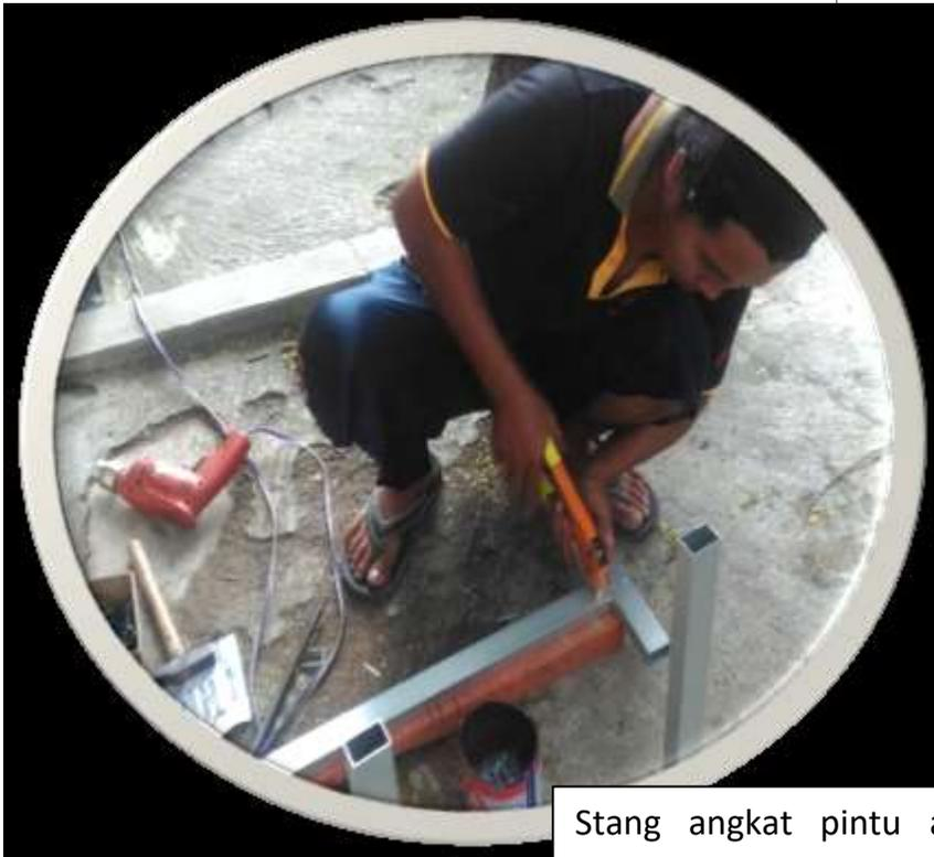
Stang angkat pintu air terbuat dari hollow aluminium 40/40, dengan semua ujung diberi tutup dan bagian vertikal diberi lubang untuk keperluan penguncian
