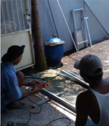
Frame pintu air dibuat dari Galvalum Canal dan Hollow. Galvalum Hollow berfungsi untuk menjepit daun pintu air saat dioperasikan naik dan turun.
