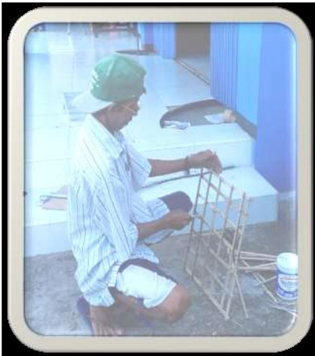
Tulangan bambu yang telah dijemur dilapisi cat anti air agar tidak terjadi peresapan air oleh bambu saat pekerjaan pengecoran.
