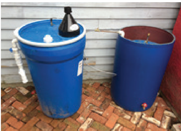
Gambar 3. Digester yang terhubung ke penampung biogas
