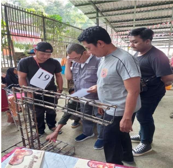
Gambar 6. Praktek Membuat Beton Bertulang Bambu (Sumber: Tim PKMS UM. Jember)
