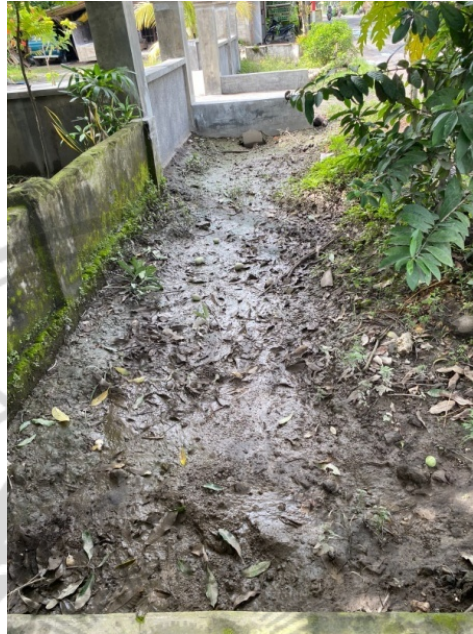
Gambar 1.2 Kondisi Drainase (Sumber : Dokumentasi Lapangan, 2023)
