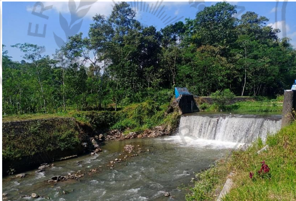
Gambar 1.1 Kondisi Bendung Tegalwaru
