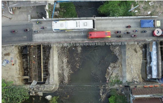
Gambar 1.1 Kondisi Jembatan Wirolegi Saat Proses Renovasi
