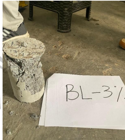
Kondisi pola retak kerucut dan geser pada benda uji beton LDPE persentase 3% setelah uji kuat tekan beton
