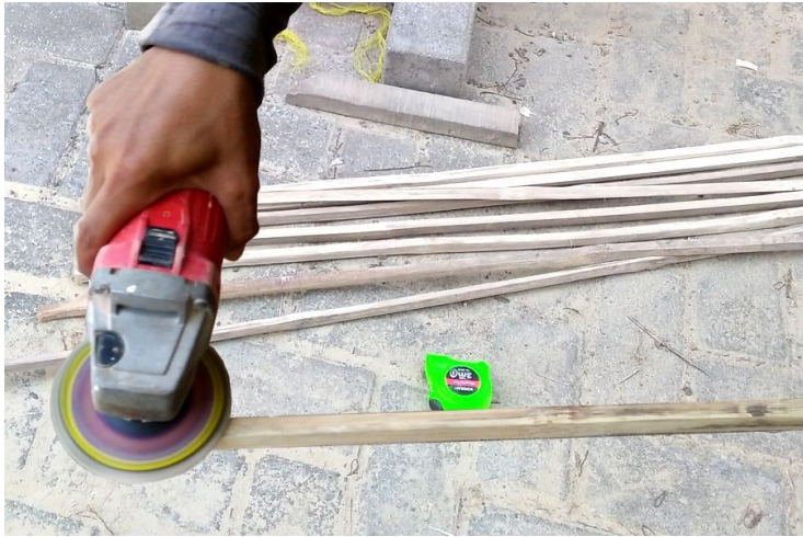
Gambar 5.6. Perapian permukaan tulangan bambu.
