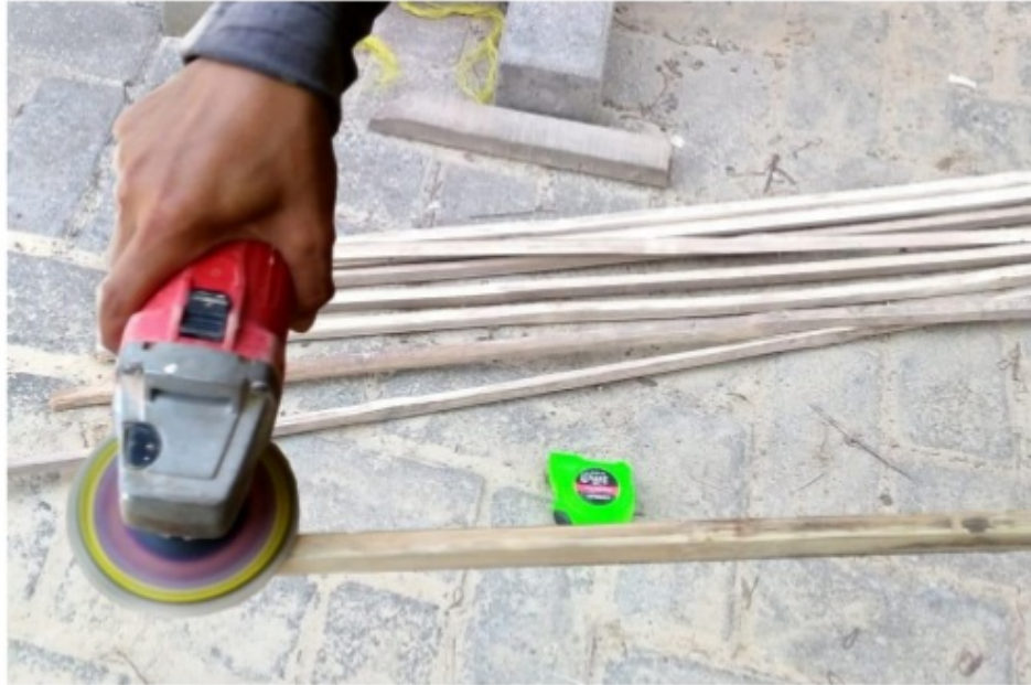
Gambar 5.6. Perapian permukaan tulangan bambu.
