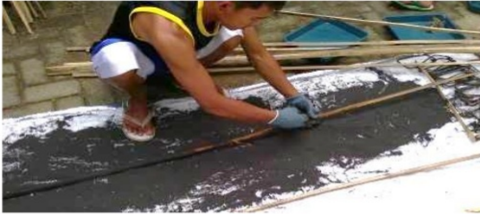
Gambar 5.10. Pelaburan pasir pada tulangan bambu setelah pelaburan perekat tahap kedua setengah kering.
