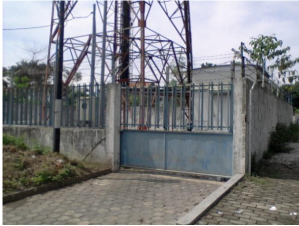
Gambar 3.2 Bangunan BTS tampak luar di salah satu jember
