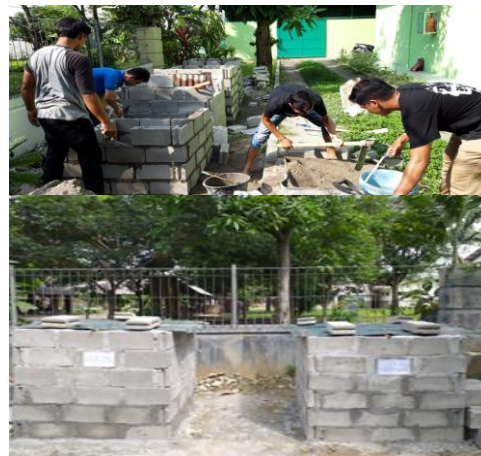
Gambar.4 Pembuatan bangunan ukuran 1 x 1 m
