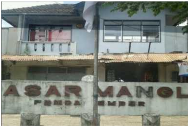
Gambar depan pasar Mangli sebelum dibangun
