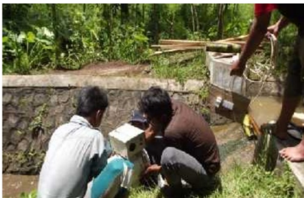
Gamabar. 4.1 Pemasangan Alternator
