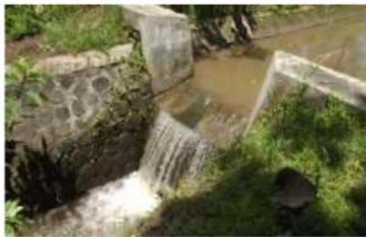
Gambar. 3.1 Sungai yang di gunakan PLTM
