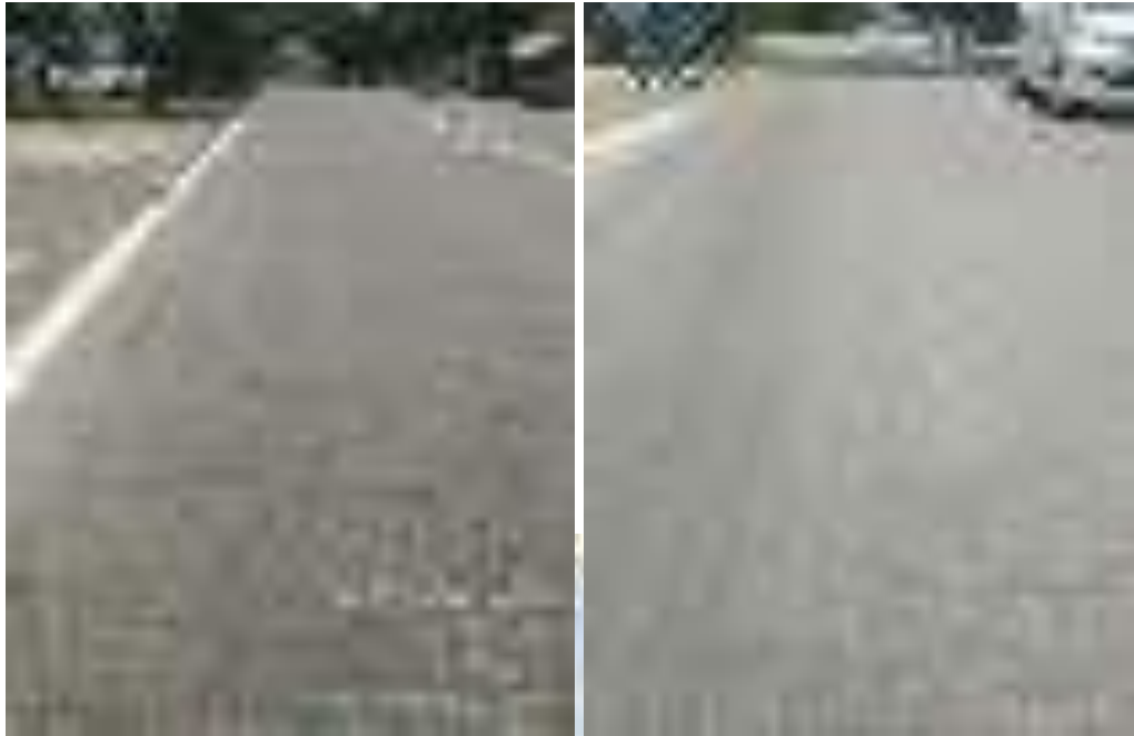
Gambar I.20. Retak Buaya (High) & Retak Melintang/Memanjang (Low)
