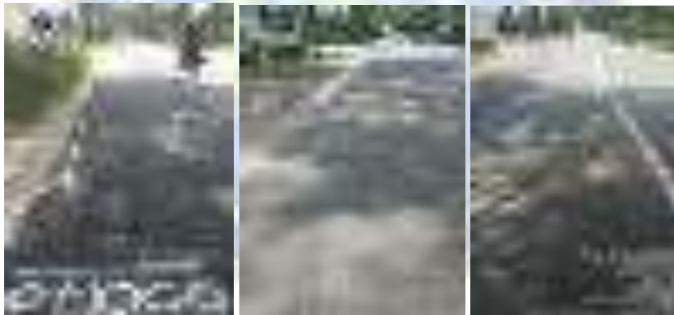
Gambar I.19. Tambalan (High), Retak Buaya (Low), & Retak Buaya (Medium)
