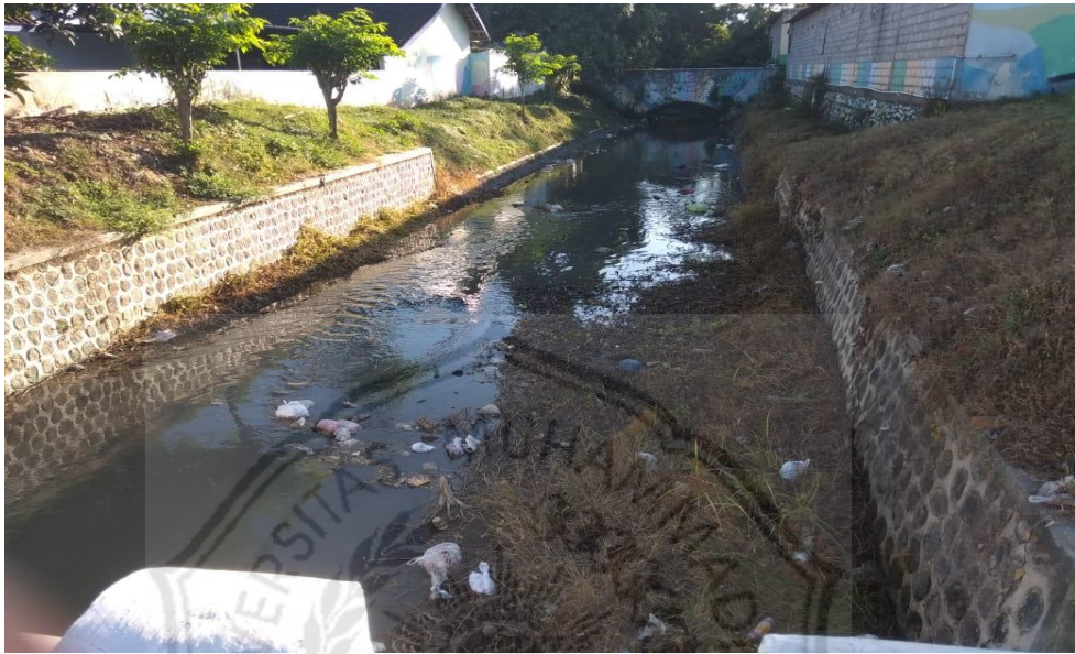
Potret kondisi sungai yang terletak di Jalan Ahmad Kusnan Desa Pesanggaran Kabupaten Banyuwangi
