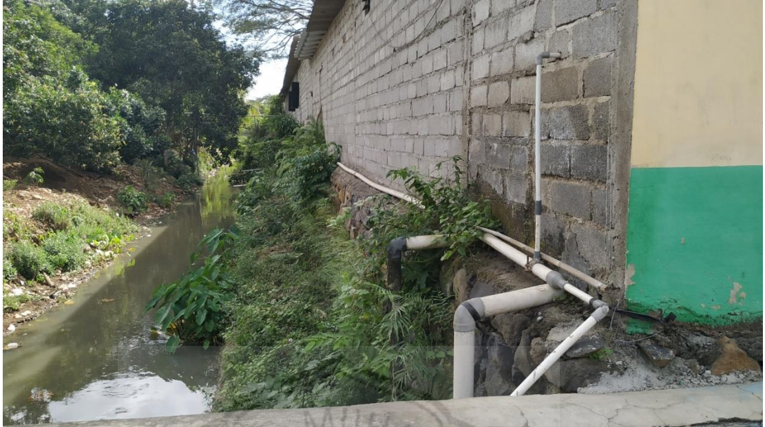
Potret Bangunan(Ruko) di Jalan Ahmad Kusnan Desa Pesanggaran Kabupaten Banyuwangi Nampak dari Samping
