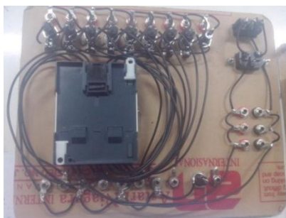
Gambar 4.6. Pemasangan kabel tiap pin PLC Zelio 12 I/O
