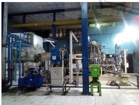
Gambar 2.9 Turbin Generator di PG. Semboro Turbin uap merupakan suatu penggerak mula yang mengubah energi potensial uap menjadi energi kinetik dan selanjutnya diubah menjadi energi mekanis dalam bentuk putaran poros turbin. Poros turbin, langsung atau dengan bantuan roda gigi reduksi, dihubungkan dengan mekanisme yang akan digerakkan. (Wikipedia, 2013). Pengertian energi potensial uap adalah
