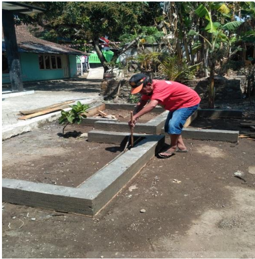
Pembukaan Bekisting Pada Benda Uji
