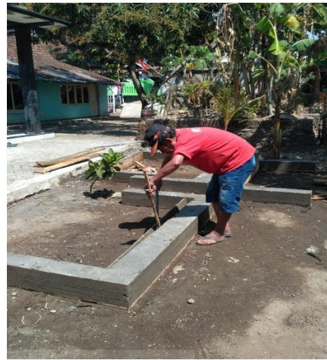
Pembukaan Bekisting Pada Benda Uji
