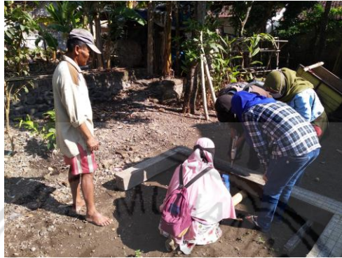
Uji Tekan Beton Menggunakan Hammer test Sebelum Pembakaran
