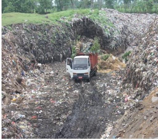
Foto Area yang dilakukan Pemrosesan menggunakan Exavator.
