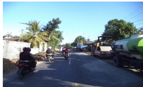
Gambar 5.15 Pemadatan dan curing CTB pada pelebaran jalan Trenggalek – Bts. Kab. Tulungagung
