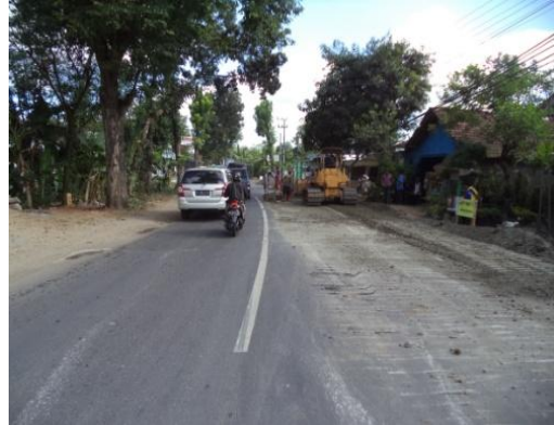
Gambar 5.14 Penghamparan CTB pada pelebaran jalan Trenggalek – Bts. Kab. Tulungagung
