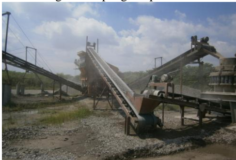
Gambar 5.13 Stone Crusher pemecahan dan pemisahan batu
