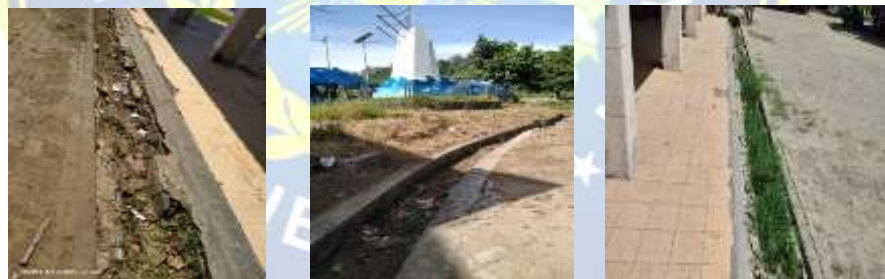
Gambar 1.1 Saluran Drainase Lokasi Penelitian
