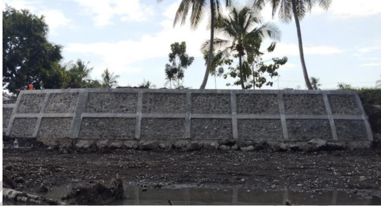
Gambar 1.1 (DPT ekisting Jembatan Besuk)
